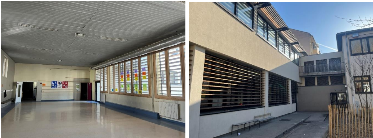
Photo n° 3 : Ecole élémentaire E. Chatin – Salle polyvalente (intérieur / extérieur) – façade sud
