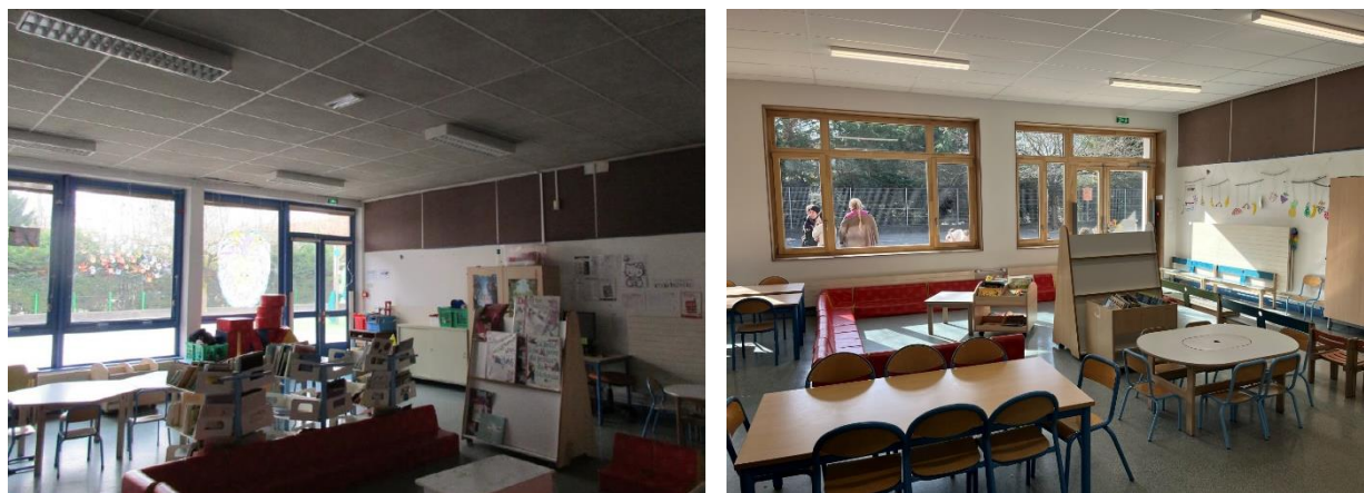
Photo n° 7 : Ecole maternelle – salle de classe (avant/après) – façade sud
