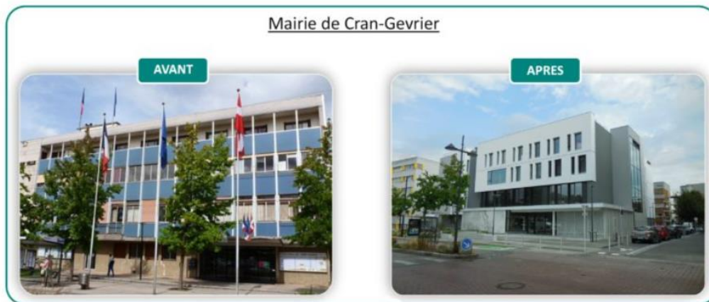
Photo n° 1 : Rénovation de la mairie de Cran-Gevrier (avant/après)
