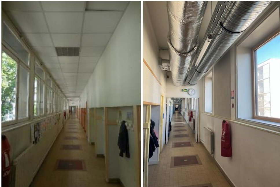
Photo n° 5 : cole élémentaire E. Chatin – couloir (avant / après)
